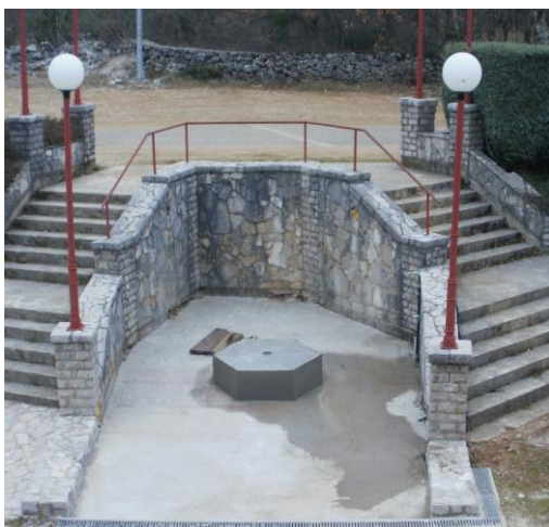
Pogled na dvokrake stepenice i na betonirani prostor između stepenica s betonskim postoljem za krstionicu.
