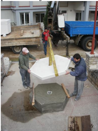
Postavljanje kamenog postolja krstionice na armirano betonsku podlogu.
