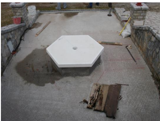
Postavljanje kamenog postolja krstionice na armirano betonsku podlogu.
