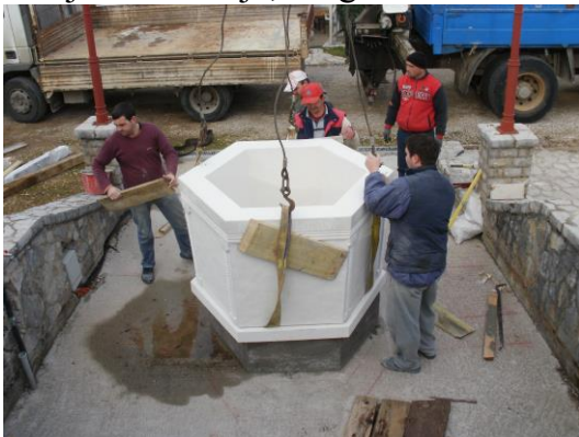
Skidanje krstionice s kamiona i postavljanje na predviđenu poziciju.
