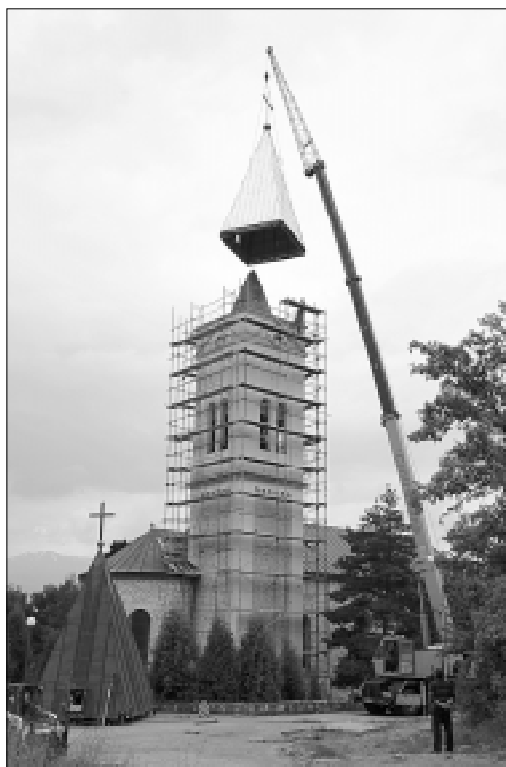
Piramida na zvoniku postavljena 1990. Oštećena je u tijeku rata. Morali smo je skinuti i postavljati novu. Na fotografiji je prikazana stara skinuta piramida i nova kako se podiže na zvonik.
