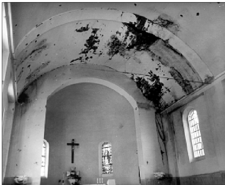
Župna crkva u Kruševu kao i mnoge obiteljske kuće, gospodarska zdanja, infrastruktura i sve drugo bilo je u tijeku rata od 1992. godine oštećeno, zapaljeno ili na različite druge načine devastirano. Slika prikazuje ranjenu crkvu i njezinu unutrašnjost.
