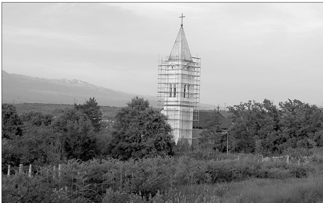
Obnova i temeljitiji zahvati na crkvi u tijeku 2008. započeti su na zvoniku. Zvonik smo do polovice završili i time prešli izvoditi radove na krovu crkve. Na fotografiji je prikazan izgled zvonika s novopostavljenim vrhom.
