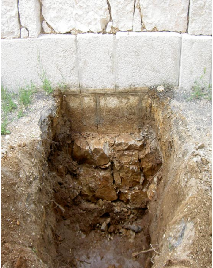
Kopanje sonde oko crkve, ovakvih sondi iskopano je šest. Kopane su sa svrhom da bi se ispitali temelji crkve. U kopanju sonde pokazalo se da su u temelje 1934. prije nego su počeli slagati kamen izlivali beton. Izvođenje takvih zahvata u to vrijeme bila je rijetkost.
